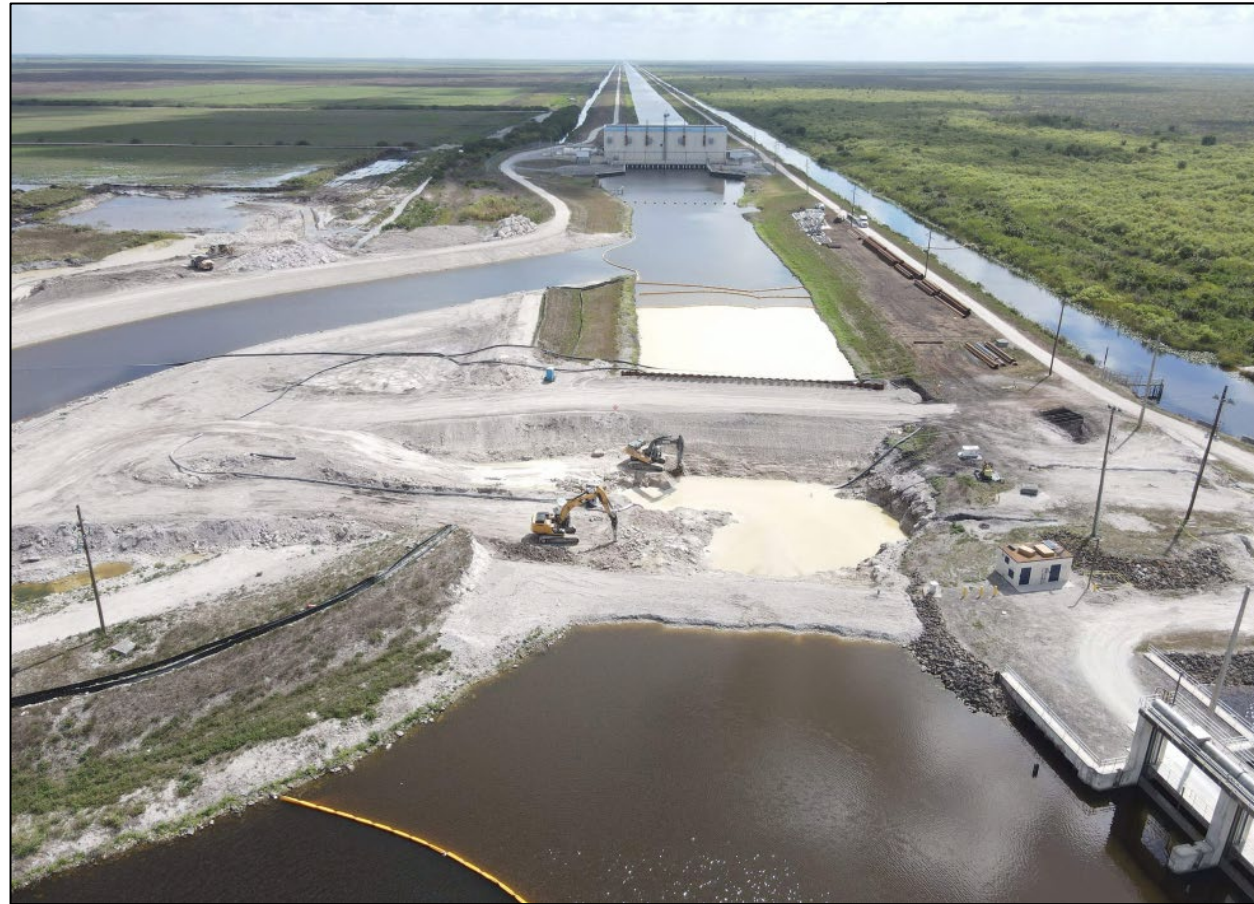
A-2 STA Construction
